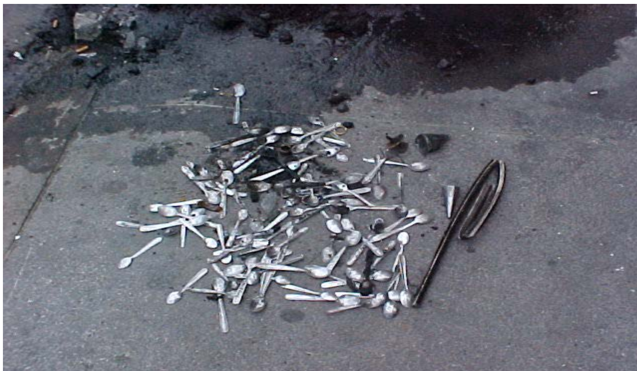
Figura 1 - Objetos Sólidos encontrados e removidos do interior da rede coletora de esgotos pelo Caminhão de Hidro-vácuo.
